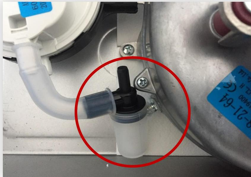
В котле установлен конденсатосборник из высокотемпературного силикона, подключенный к вентилятору через металлическую трубку Пито
